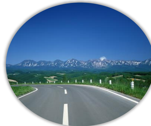
Автодорога Душанбе – Кабул Нижний Пяндж
